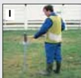
1 Le socle est enfoncé dans le sol à l'aide d'une masse. Ne pas oublier le capot protecteur.
